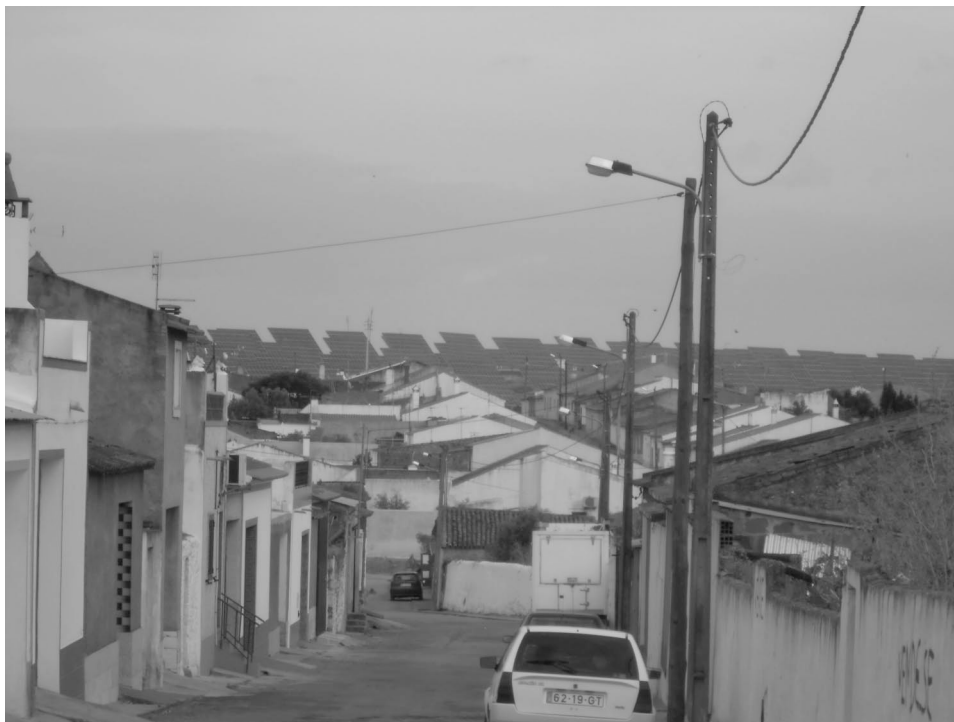
Figura 2 Vista da Central Fotovoltaica a partir da Amareleja
